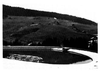
Bild 7 Blick auf das Ausgleichbecken Gneida (20 000  $\mathrm{m^3}$  Inhalt) mit Einlaufbauwerk.
