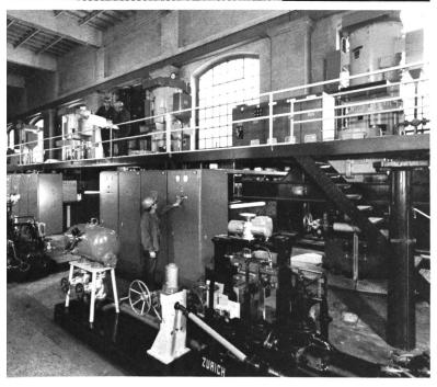
Bild 4, oben. Die Gleichstromgeneratoren 1 bis 6 im Kraftwerk Rheinfelden der Aluminium-Hütte GmbH. (Photo Wehninger)
