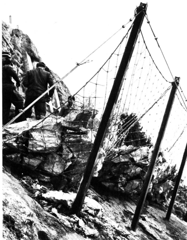
Bild 1 Steinschlag-Verbauung zum Schutz der BLS Lötschberg-Südrampe. Rechtecknetze 2,7 x 3,0 m, Maschenweite 20 cm. Belastung gemäss Bild rund 8 m 3 Fels.
