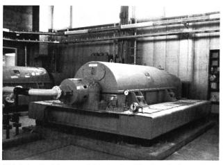
In «Zentrifugen» erfolgt eine beschleunigte Sedimentation in einem Fliehkraftfeld. Für Kommunalschlämme haben sich die kantierzentrifugen durchgesetzt. (Foto Bucher/BS)
