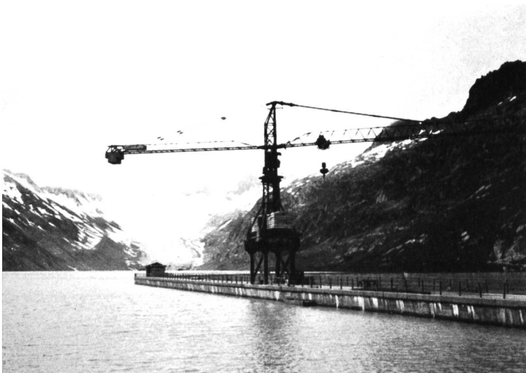
Bild 3 Bauinstallationen auf der Staumauer Oberaar.
