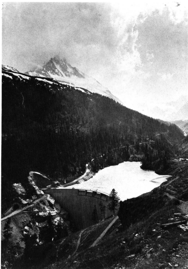
Bild 1 Die 74 m hohe Bogenmauer Z'Mutt staut das Wasser aus dem Gornergletscher und aus den linksufrigen Fassungen des Zermattertales auf etwa 2000 m Höhe. Dieses wird von dort auf 2400 m hochgepumpt und fliesst sodann in der Sammelleitung dem Staubecken der Grande Dixence zu.
