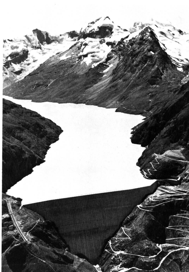
Bild 2 Die Gewichtsmauer Grande Dixence hat ein Betonvolumen von 6 Mio m 3 und eine Höhe von 284 m. Die grösste Breite am Fuss der Mauer beträgt 198 m; die Krone ist 15 m breit und 700 m lang. Das Volumen des Stausees erreicht 400 Mio m 3 .
