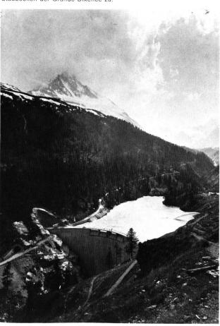
Bild 2 Die Gewichtsmauer Grande Dixence hat ein Betonvolumen von 6 Mio m³ und eine Höhe von 284 m. Die grösste Breite am Fuss der Mauer beträgt 198 m; die Krone ist 15 m breit und 700 m lang. Das Volumen des Stausees erreicht 400 Mio m³.
