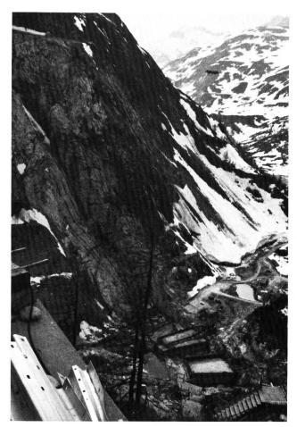
Bild 7 Rechtes Widerlager der Talsperre Sameralm; mit dem Einbringen des Betons ist begonnen worden.
