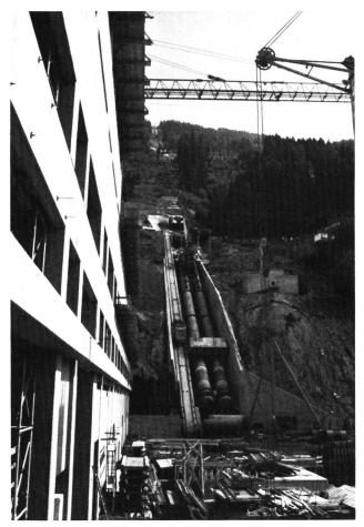
Bild 3 Druckleitung und Zentrale Rottau der Hauptstufe der Kraftwerkgruppe Malta in Kärnten.
