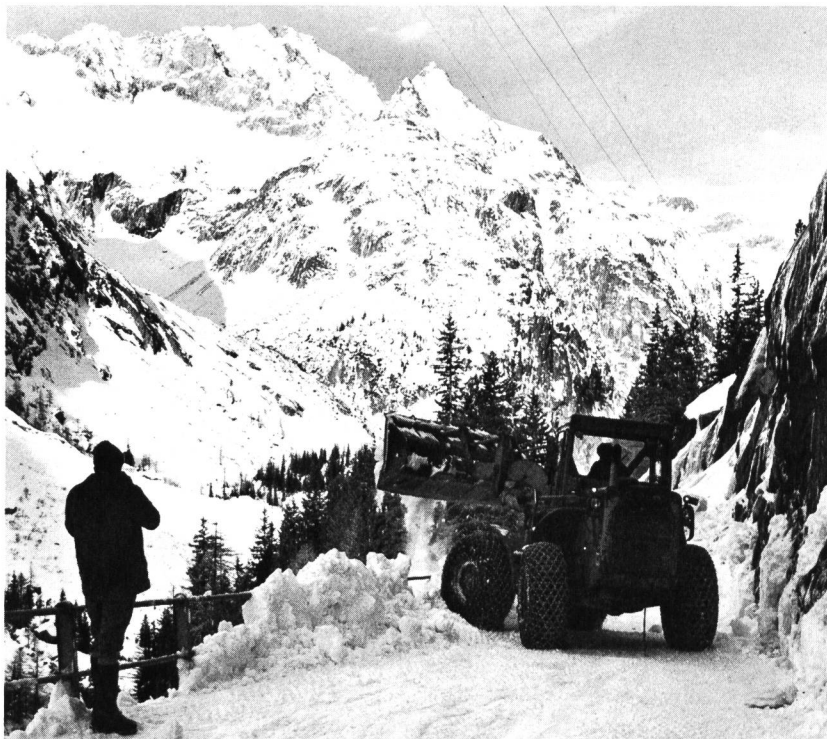
Bild 18 Zufahrtsstrasse zur Gersteneegg.
