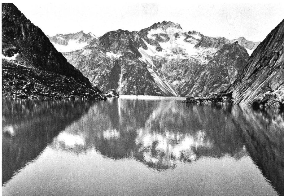
Bild 7 Stausee Gelmer mit Blick gegen Talsperre.
