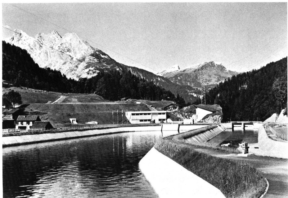
Bild 25 Zentrale, Ausgleichsbecken und Wehr Hopflauen im Gadmental.
