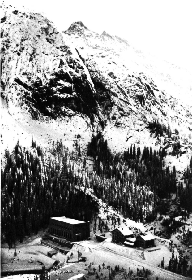
Bild 8 Kraftwerk Handeck I und Wohnhäuser für das Betriebspersonal.
