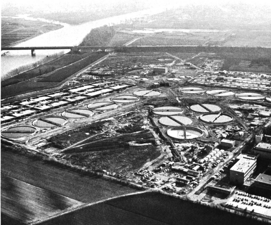
Bild 2 Mechanisch-biologische Gross- Kläranlage der BASF, Ludwigsha- fen, dimensioniert für 7,2 m 3 /s Trockenwetteranfall (Ausbau 1974/ 75) und 8,6 m 3 /s (Endausbau).
