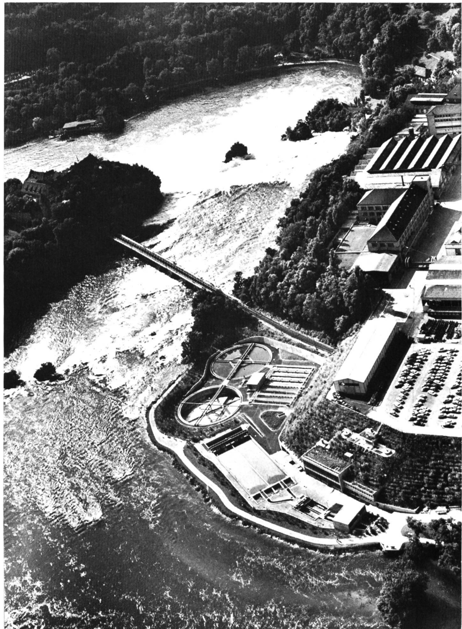
Bild 7 Abwasserreinigungsanlage «Röti» und Rheinfall mit Schloss Laufen (links). Die seit 1970 in Betrieb stehende Kläranlage «Röti» ist ein Gemeinschaftswerk der Städte Schaffhausen und Neuhausen am Rheinfall mit den zürcherischen Gemeinden Feuerthalen und Flurlingen für ca. 100 000 EGW. Trockenwetteranfall 800 l/s. Besondere Beachtung verlangte die gute Eingliederung in das Gebiet zwischen Rhein, Rheinfall und Industrieanlagen. Die beiden Faulräume und das Dienst- und Betriebsgebäude befinden sich in der Böschung der 20 m hohen Auffüllung unter dem Parkplatz.
