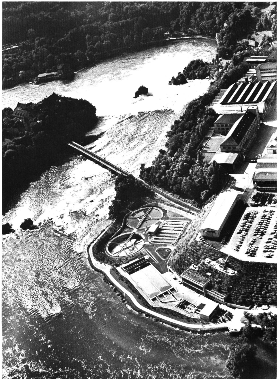
Bild 7 Abwasserreinigungsanlage «Röti» und Rheinflall mit Schloss Laufen (links). Die seit 1970 in Betrieb stehende Kläranlage «Röti» ist ein Gemeinschaftswerk der Städte Schaffhausen und Neuhausen am Rheinflall mit den zürcherischen Gemeinden Feuerthalen und Flurlingen für ca. 100 000 EGW. Trockenwetteranfall 800 l/s. Besondere Beachtung verlangte die gute Eingliederung in das Gebiet zwischen Rhein, Rheinflall und Industrieanlagen. Die beiden Faulräume und das Dienst- und Betriebsgebäude befinden sich in der Böschung der 20 m hohen Auffüllung unter dem Parkplatz.
