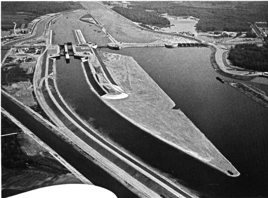
Fig. 11 Aménagement de Gamsheim 1974: Vue générale côté amont; de gauche à droite: le canal de dé- viation de l'Ill, le canal de navi- gation, les écluses comprenant deux sas de 270 x 24 m, l'usine hydro-électrique, la digue de fer- meture du Rhin et le barrage mo- bile.
