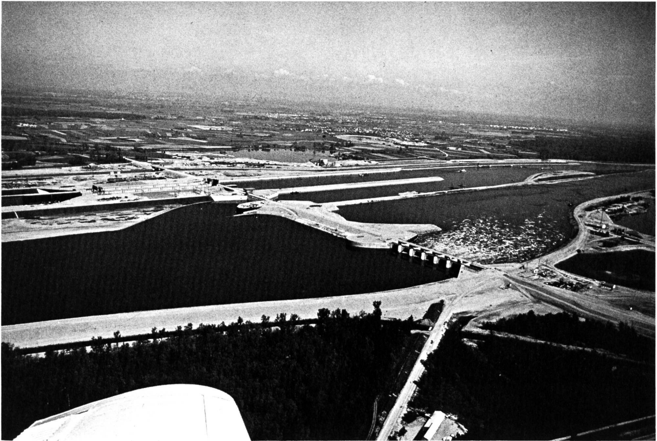
Fig. 13 Aménagement de Gamsheim 1974: Vue générale depuis la rive droite: au fond la plaine d'Alsace.
