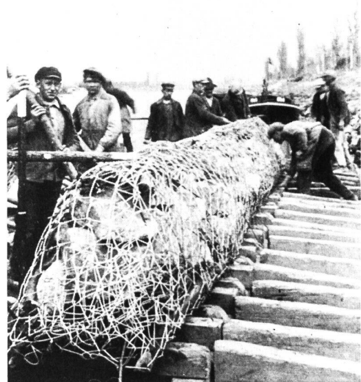
Bild 8 Senkwürste für den Bau von Bühnen zur Niederwasserregulierung des Oberrheins.
