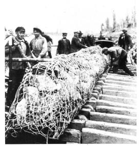
Bild 8 Senkwürste für den Bau von Buhnen zur Niederwasserregulierung des Oberrheins.
