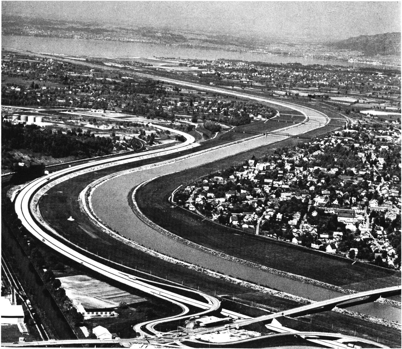
Bild 6 Internationaler Rhein von der Brücke Au bis zum Bodensee; Mittelgerinne, Vorland, Hochwasserdamm.
