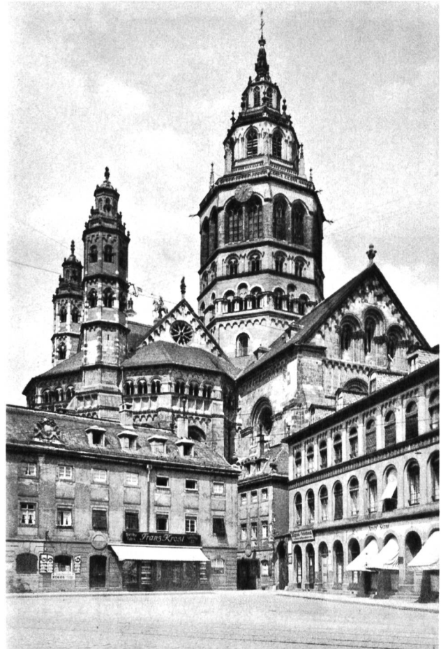
Bild 23 Mainz: Der spätromanische Dom, dessen Vierungsturm jedoch erst im 18. Jahrhundert in nachgotischen Formen vollendet wurde, gewinnt durch die erhaltenen alten Häuser den richtigen Masstab für seine Größe.
