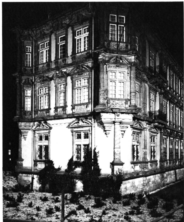
Bild 26 Mainz: In reicher Spätrenaissance steht das einstige Kurfürstenschloss an der Rheinpromenade.
