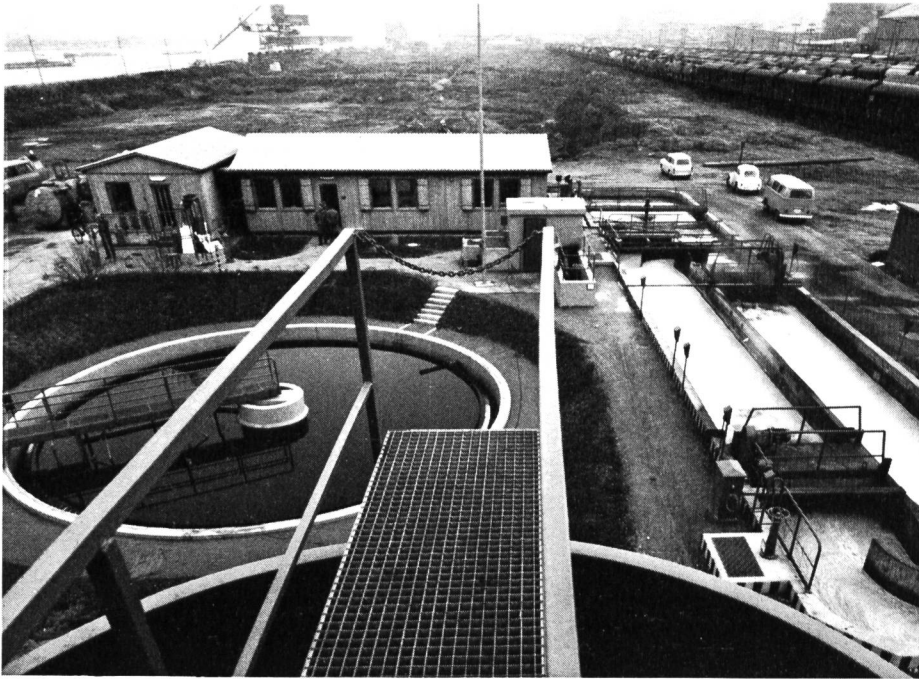
Bild 1: Versuchskläranlage Der Kostenaufwand für diese Anlage betrug etwa 2 Mio DM und erforderte 2 Mio DM jährliche Betriebskosten. Auf Basis dieser Anlage konnte im Frühjahr 1972 eine Aufgabenstellung für die Reinigung des Abwassers formuliert werden.
