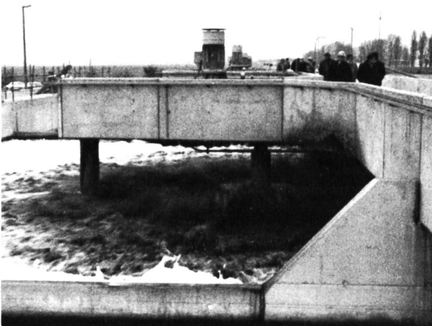
Bild 8 Brücke mit zwei «Superquirlen» im Betrieb.
