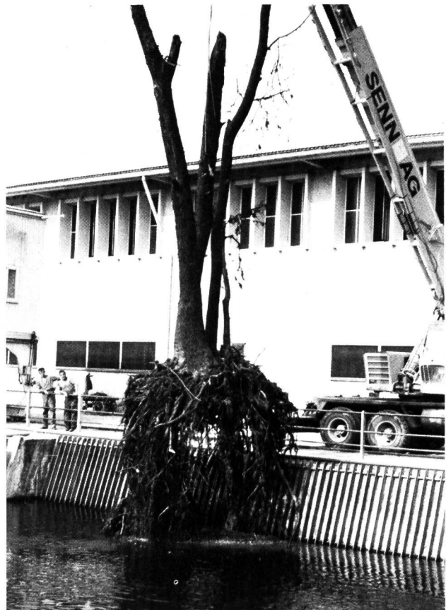
Bild 1 Kraftwerk Wildegg-Brugg: Beispiel von «Grobgeschwemmsel».
