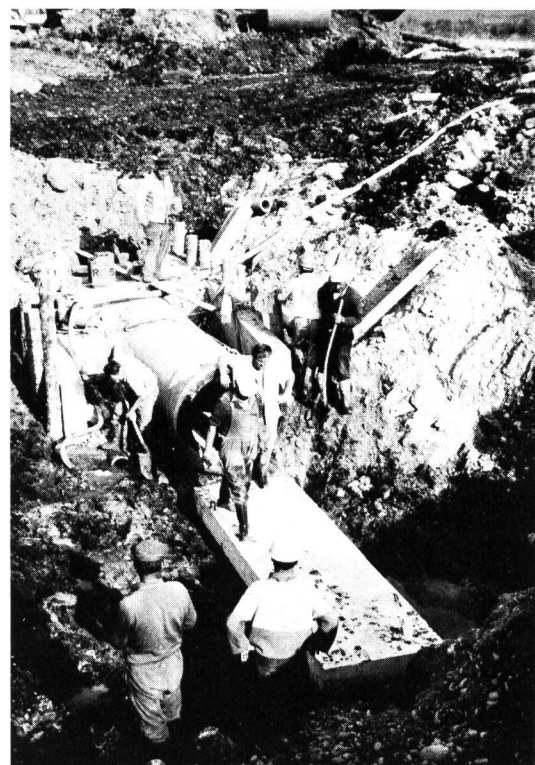
Bild 12 Pfahl-Platten-Gründung des Bibertal-Hauptsammlers.
