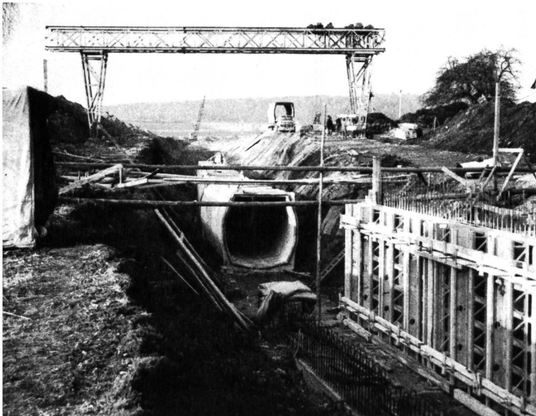
Bild 14 Verbandssammler Singen-Ramsen, Ausführung mit vorfabrizierten Elementen.
