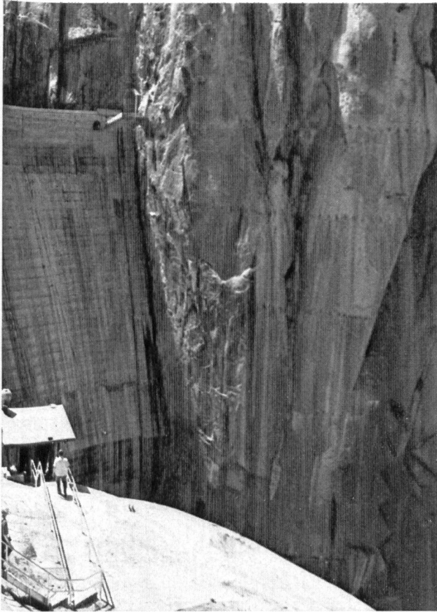
Bild 3 Sperrstelle Aldeadávila; Felssicherung im linken Widerlager durch mehrere Reihen vorgespannter Anker zur Verhinderung von Abschalungen längs Talklüftungen im kompakten Granit.
