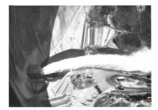
Bild 16 Der anlässlich des Besuches der Talsperre Atazar in Betrieb gesetzte Grundablass demonstriert eindrücklich die gewaltige Wasserkraft
