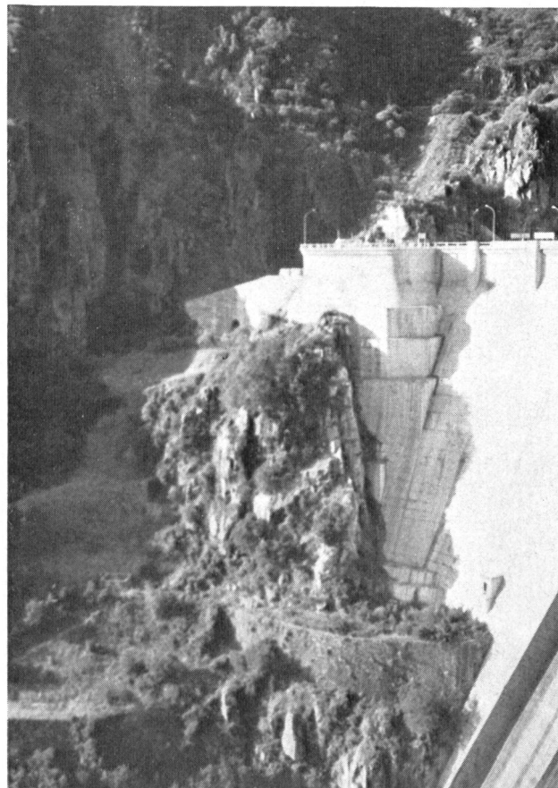
Bild 6 Sperrstelle San Esteban; Verstärkung des Widerlagers auf der linken Talseite durch Ueberbrückung einer Störungszone mit einem Betonsporn.
