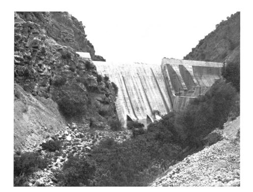
Bild 3 Talseitige Ansicht der Gewichts- und Pfeilerstaumauer El Kansera, die kürzlich um 5 m erhöht wurde.
