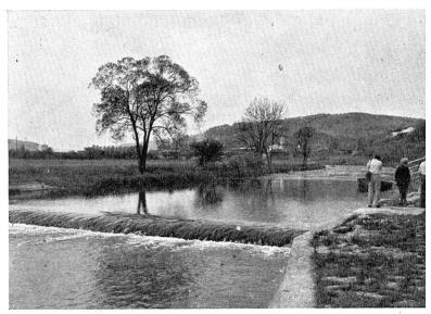
Bild 2 Wasserfassung an der oberen Donau für den Umleitungsstollen Immendingen-Möhringen.
