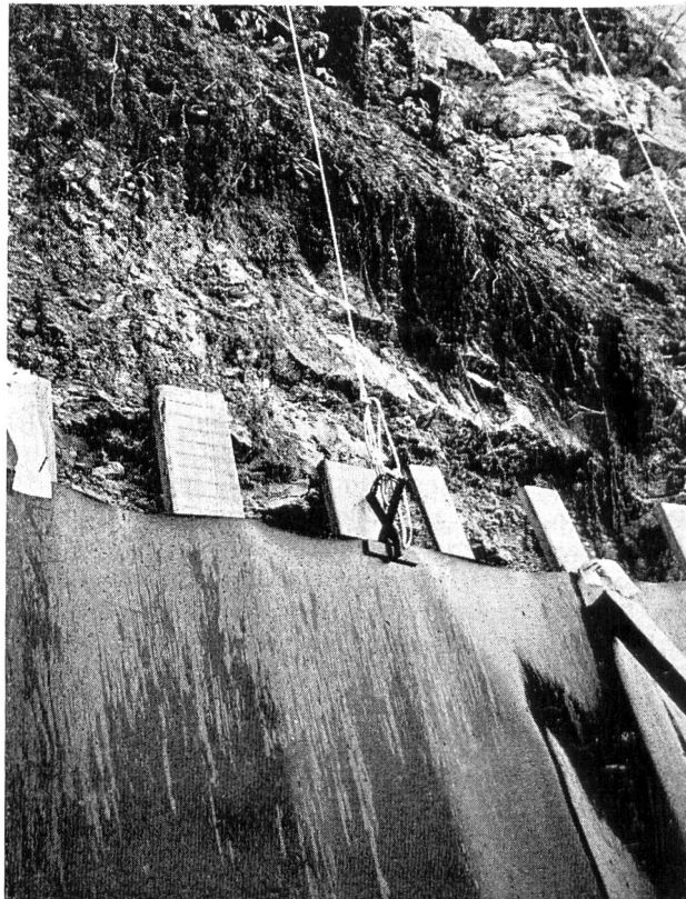
Bild 6 Hochziehen der Folien im Bereich der Felswand.
