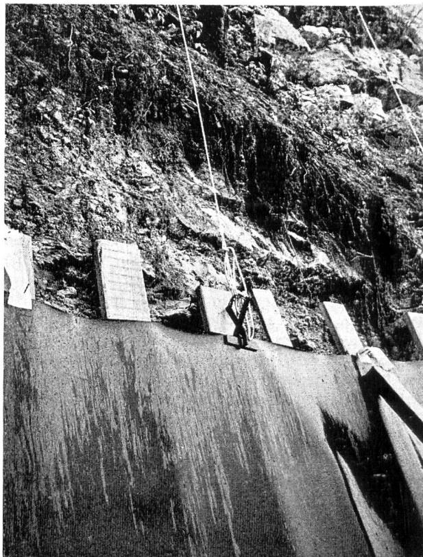
Bild 6 Hochziehen der Folien im Bereich der Felswand.
