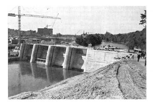
Bild 4 Stauwehr des Reusskraftwerkes Bremgarten-Zufikon, oberwasserseitig.
