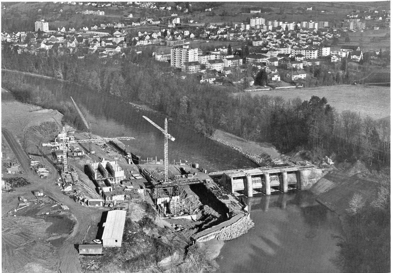
Bild 5 Flugaufnahme der Baustelle für Maschinenhaus und Wehr des Reusskraftwerkes Bremgarten-Zufikon: Rechts die Wehrröffnungen 2 bis 5, in der Bildmitte die Maschinenhausbaugrube, links das Unterwerk (Photo Comet, Zürich, vom 8. 1. 74).
