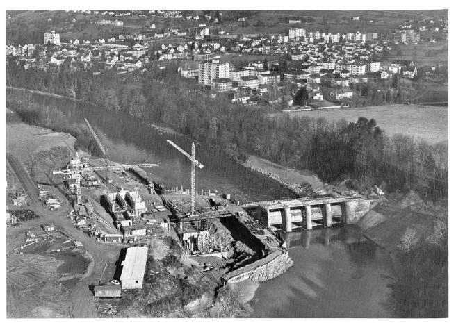
Bild 5 Flugaufnahme der Baustelle für Maschinenhaus und Wehr des Reusskraftwerkes Bremgarten-Zufikon: Rechts die Wehröffnungen 2 bis 5, in der Bildmitte die Maschinenhausbaugrube, links das Unterwerk (Photo Comet, Zürich, vom 8. 1. 74).
