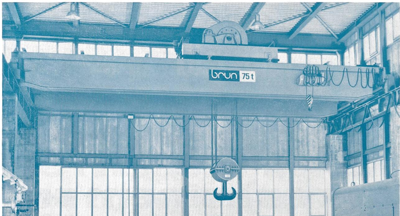
Nicht alle innerbetrieblichen Transportprobleme können durch Einsatz von Standardkranen gelöst werden. Hiefür baut BRUN seine Schwerlastkrane mit Windwerkkatzen. Die Hub-, Katz- und Kranfahrgeschwindigkeiten sowie die nötige Tragkraft können vom Kunden gewählt werden.
