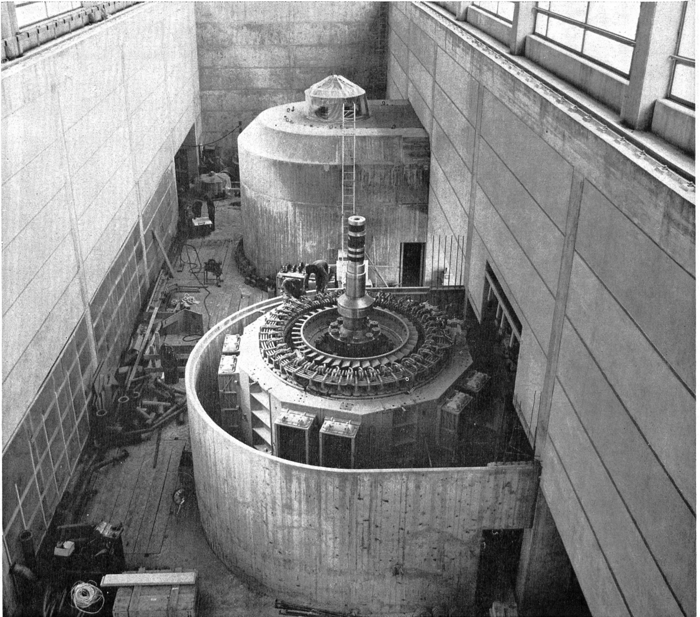
Die beiden Generatoren der Zentrale La Bâtiaz (Electricité d'Emosson SA) während der Montage. Leistung je 90 MVA bei 428 U./min.
