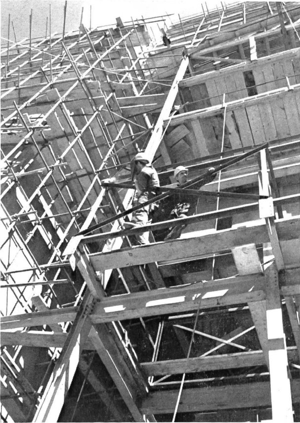
Bild 6 Aufbau der Installationen für die Talsperre Gigerwald.
