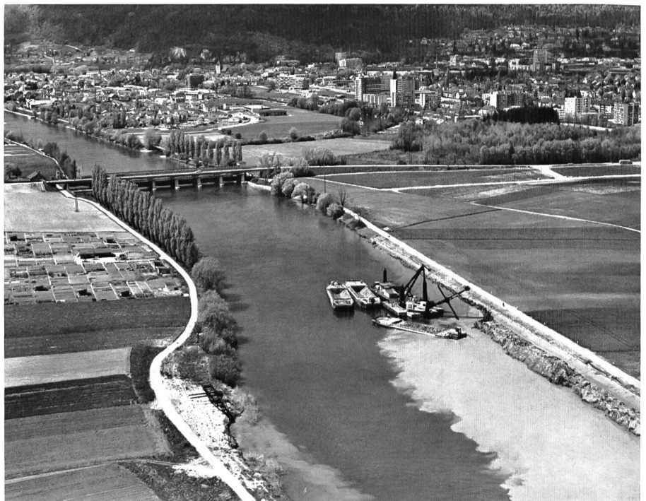
Bild 8 Verbreiterung des Nidau-Büren-Kanals unterhalb des Seeregulierwehrs in Port; im Hintergrund die Stadt Biel.
