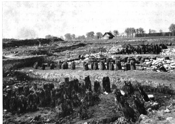
Bild 4 Anlässlich der umfangreichen und minuziösen archäologischen Studien von Dr. Hanny Schwab. Ausgegrabene Joche einer römischen Militärbrücke an der Broye bei Le Randet (1. Jh. n. Chr.).
