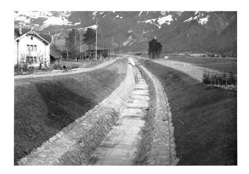
Bild 1 Der Saarableitungskanal bei Trübbach vor der Einleitung des Wassers, Blickrichtung rheinabwärts.
