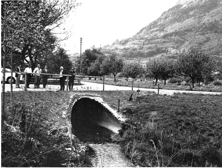
Bild 9 Armcoüberbrückung eines «Giessens» unter Beibehaltung des Baumbestandes.
