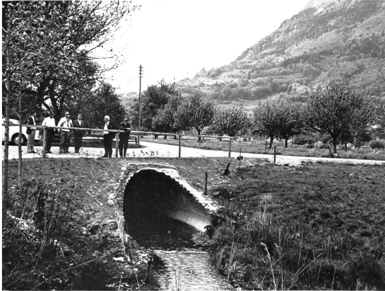
Bild 9 Armcoüberbrückung eines «Giessens» unter Beibehaltung des Baumbestandes.
