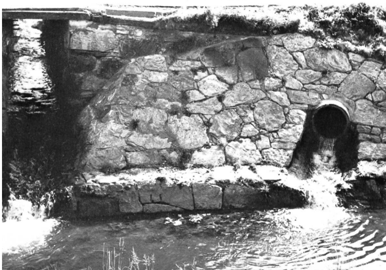
Bild 10 Einmündung einer Entwässerungsleitung.
