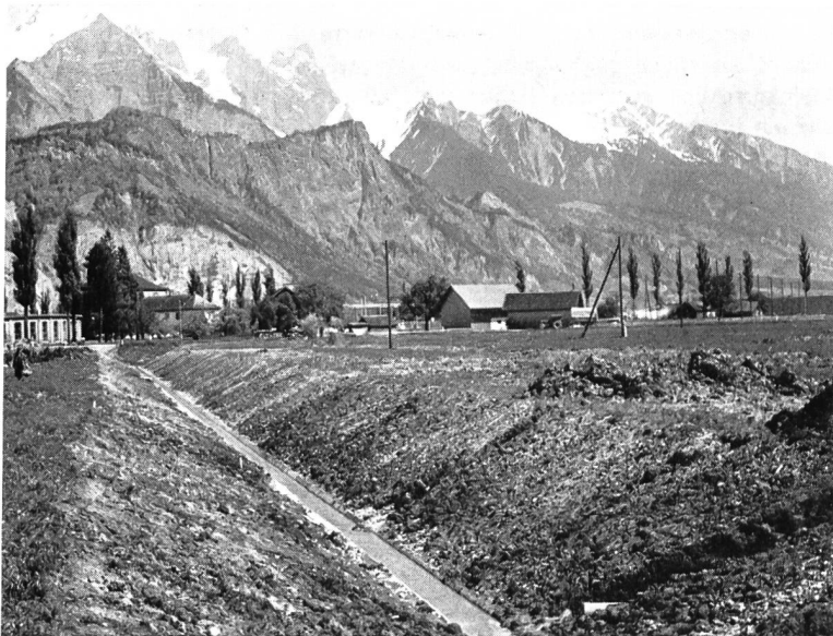
Bild 4 Wolfsrietgraben mit Sohlenschutz und Drainageeinmündungen.
