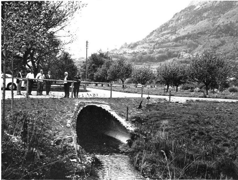
Bild 9 Armcoüberbrückung eines «Giessens» unter Beibehaltung des Baumbestandes.
