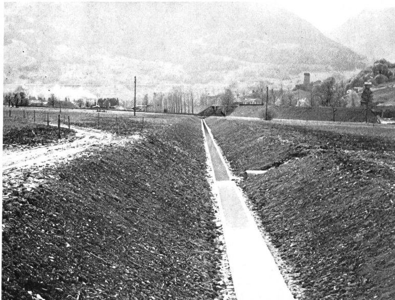
Bild 5 Neuer Vorflutgraben; zufolge geringem Gefälle war der Einbau einer Betonsohle nötig.
