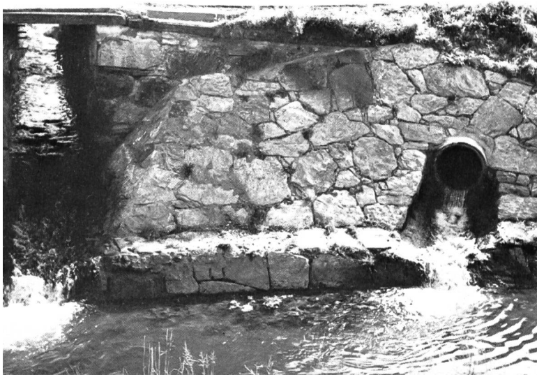
Bild 10 Einmündung einer Entwässerungsleitung.
