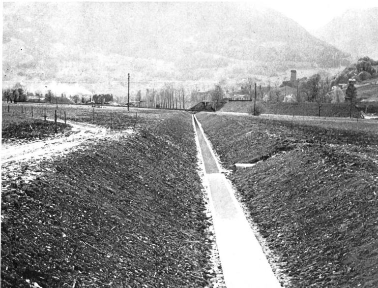
Bild 5 Neuer Vorflutgraben; zufolge geringem Gefälle war der Einbau einer Betonsohle nötig.
