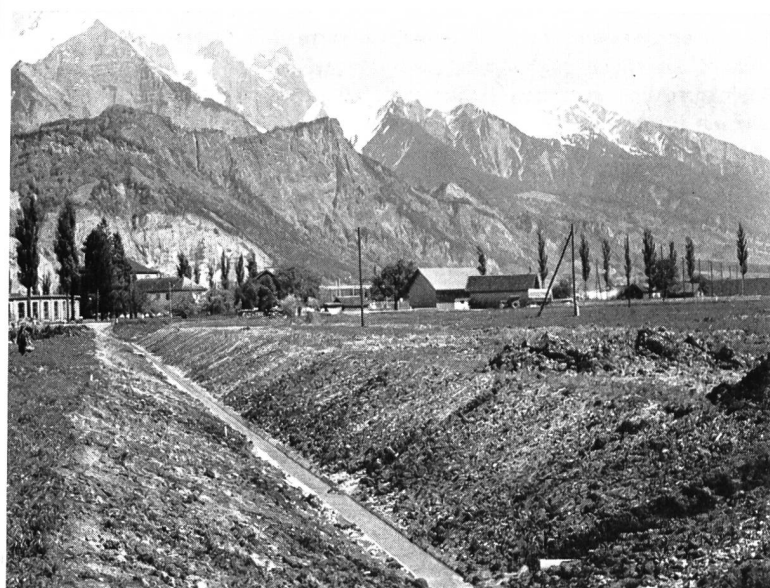
Bild 4 Wolfsrietgraben mit Sohlenschutz und Drainageeinmündungen.
