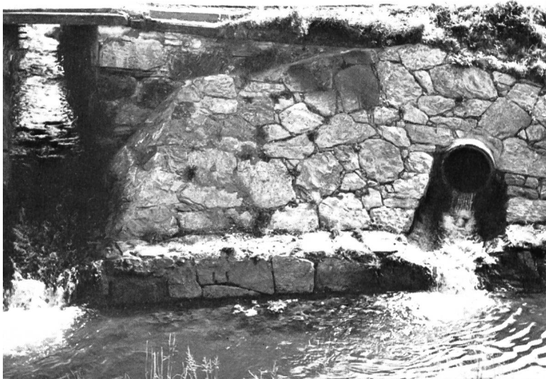
Bild 10 Einmündung einer Entwässerungsleitung.
