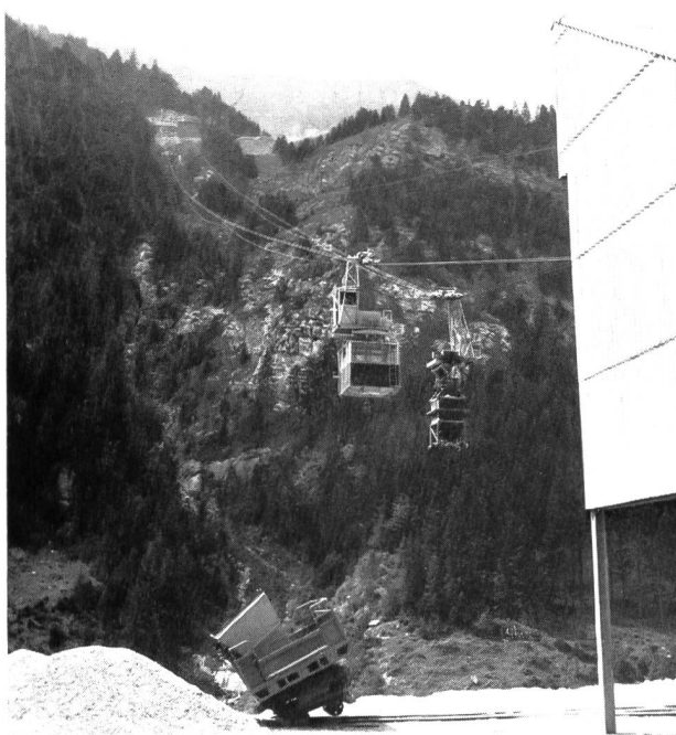
Bild 3 18- und 5-Tonnen-Seilbahnen zum Wasserschloss Mapragg.
