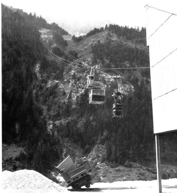
Bild 3 18- und 5-Tonnen-Seilbahnen zum Wasserschloss Mapragg.
