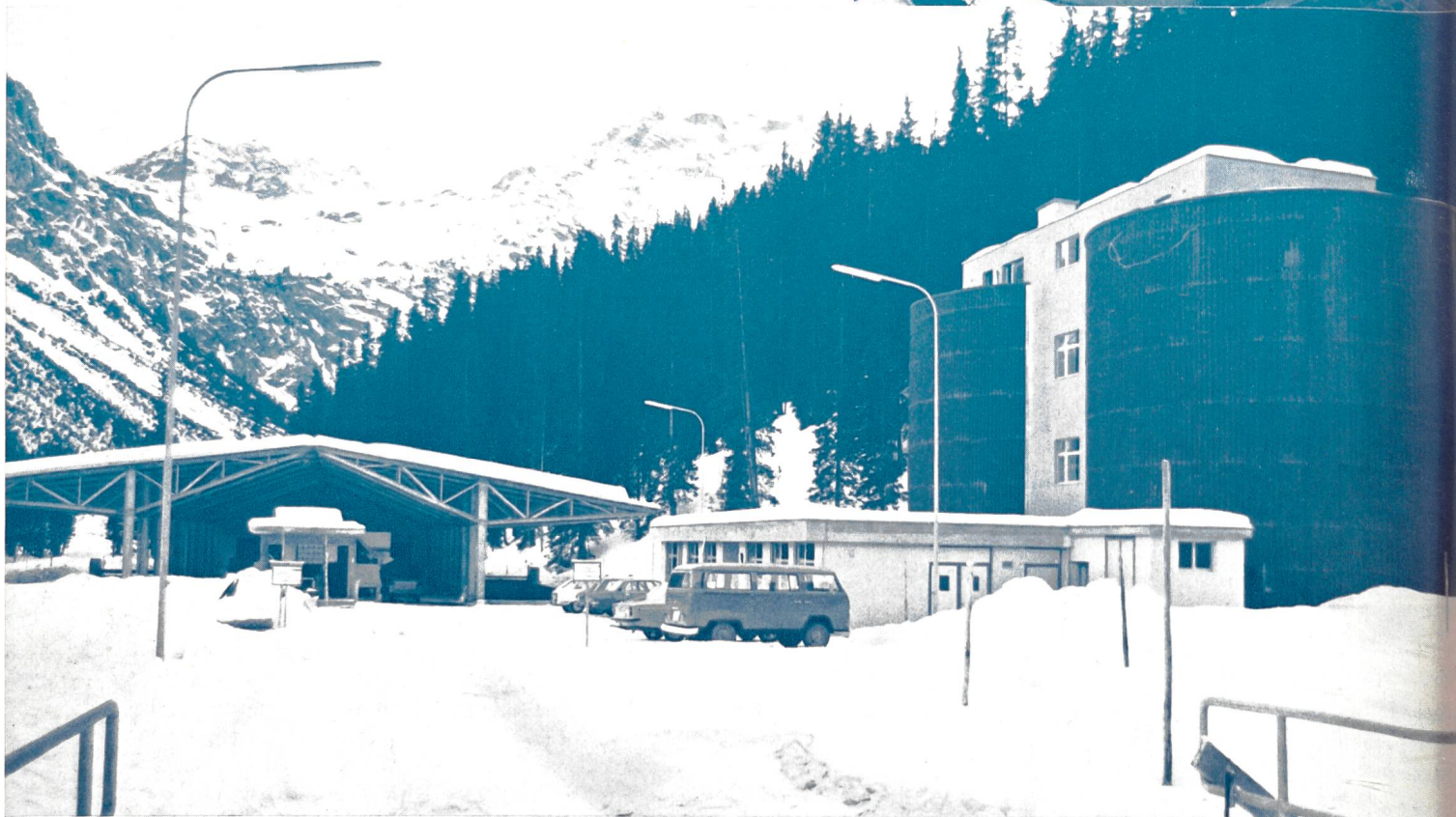
Aufnahmen der ARA Arosa Inbetriebnahme Dezember 1972 Ausführung in Arbeitsgemeinschaft durch unsere Filiale Chur
