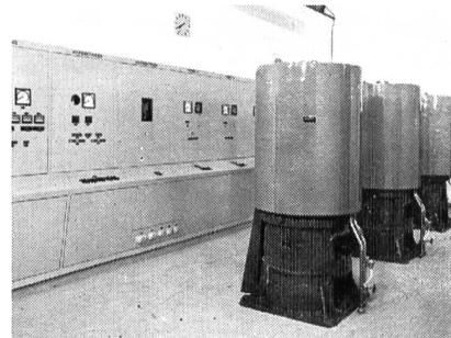
Vermehrt werden ruhiglaufende Wasserwerkspumpen verlangt. Weil die Pumpwerke oft bei Wohnsiedlungen liegen. Deshalb rüsten wir unsere Bohrlochpumpen mit Schwingungsdämpfern aus, oder wir liefern Tauchmotorpumpen, bei denen Pumpe und Motor direkt in den Grundwasserschacht versenkt werden. Bild: Seewasser-pumpwerk Meilen.
