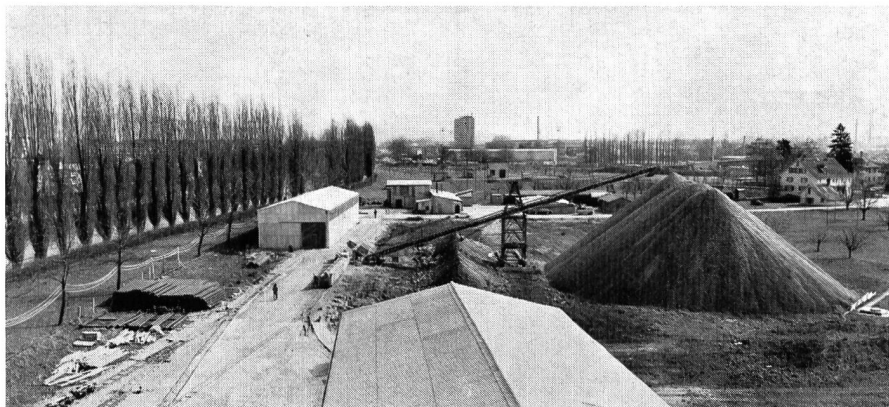
Bild 30 Installationsplatz für die Stollenbauten auf dem Hard- hofareal; Maschinenbaracken, Halle für die Stahlblech- Bearbeitung der Rohre, Halle für die Erstellung der Tübbinge sowie Deponie des Stollenausbruch- Materials.
