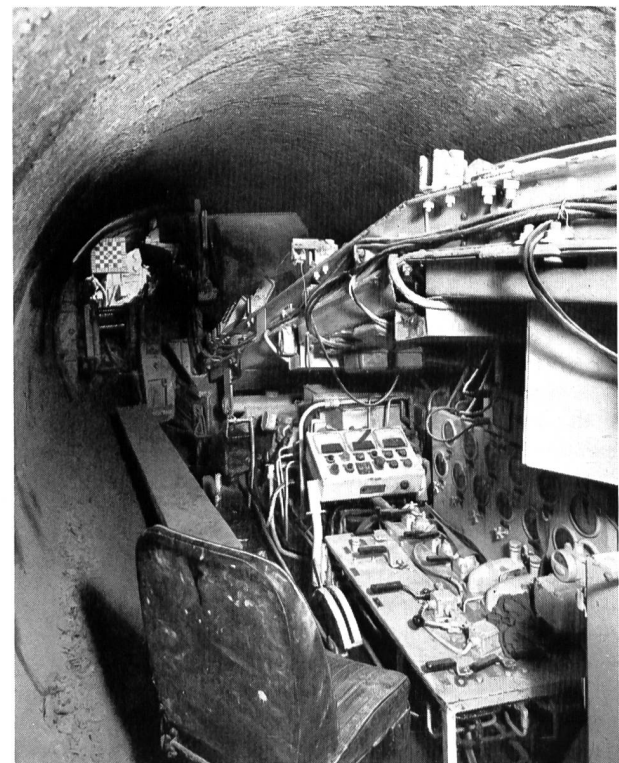
Bild 29 Tunnelvortriebsmaschine «Robbins» im Stollen Hardhof — Strickhof/Höngg (max. Bohrleistung 28 m/Tag).
