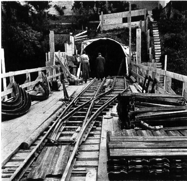
Bild 28 Eingangsportalstollen Hardhof — Strickhof/Höngg; Ausbrucharbeiten.
