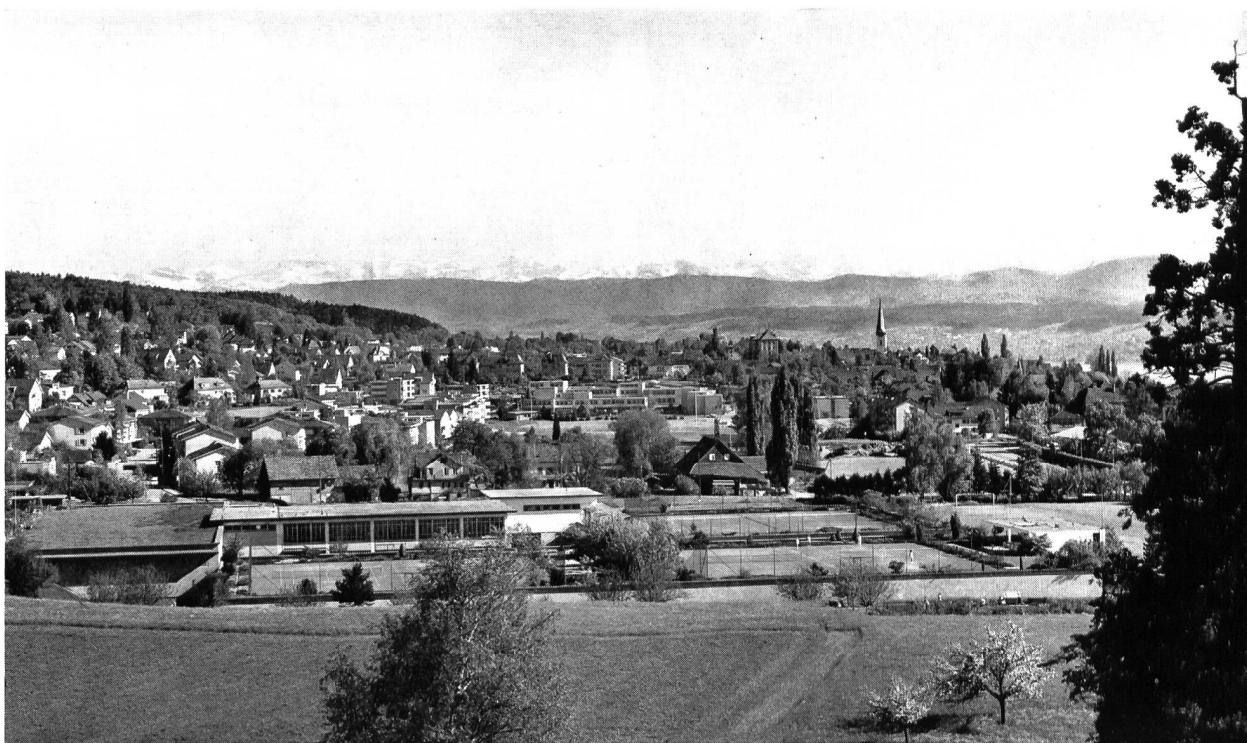
Bild 15 Uebersicht des Seewasserwerkes Lengg vor der Erweiterung.
