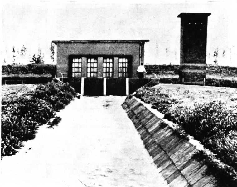
Bild 5 Blick auf eine der vielen ähnlichen Pumpstationen.
