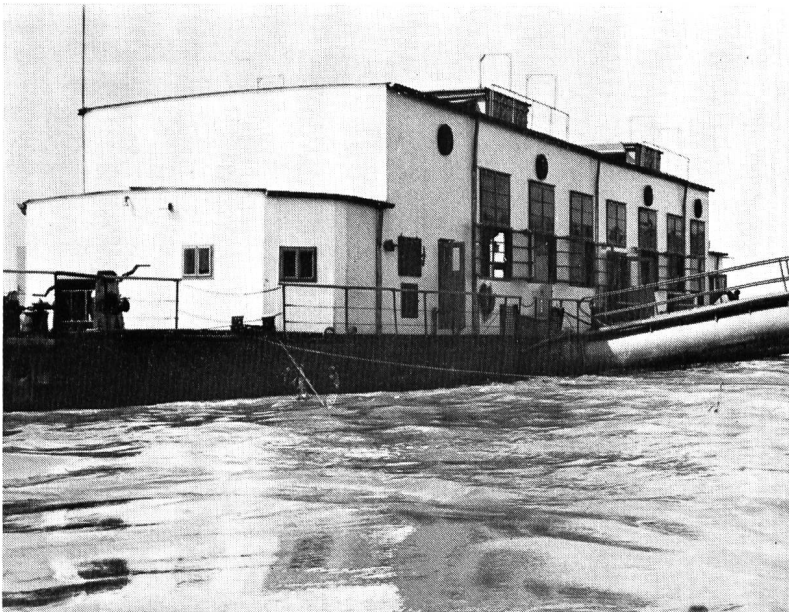
Bild 9 Schwimmende Pumpanlage in Bulgarien.
