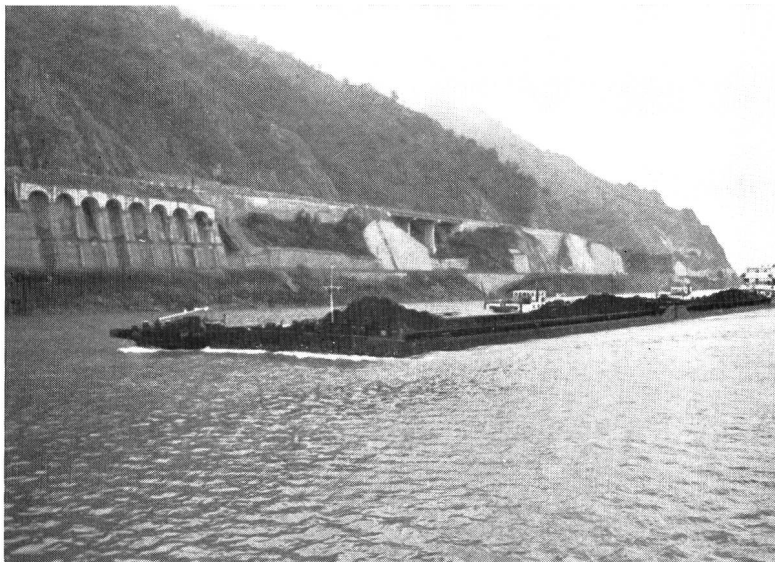
Bild 19 Kohlentransport oberhalb des Kraftwerks «Eisernes Tor», am rumänischen Ufer; im steilen Hang befinden sich die verlegten Trasses von Strasse und Eisenbahn.
