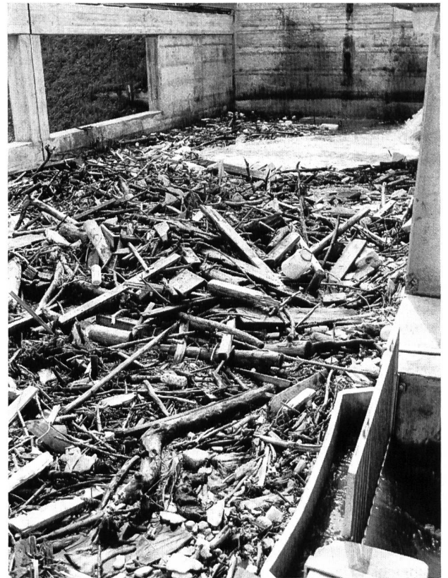
Bild 7 Typisches Geschwemmselbild: Holz, Plastikgefasse, Schaumstoffe. In rechter unterer Bildecke der Beckenuberlauf.
