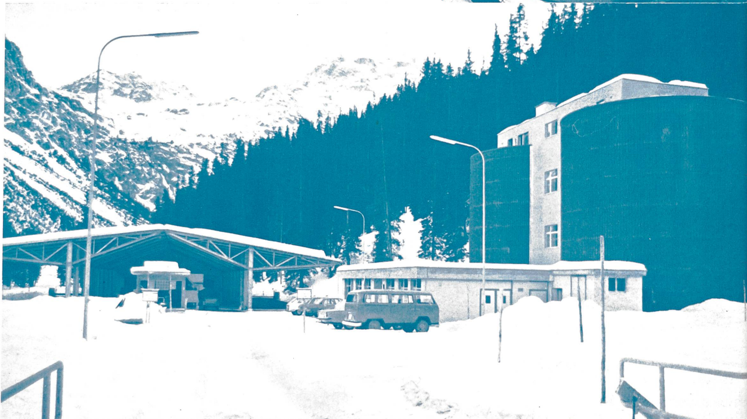
Aufnahmen der ARA Arosa Inbetriebnahme Dezember 1972 Ausführung in Arbeitsgemeinschaft durch unsere Filiale Chur
