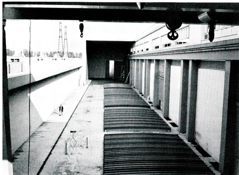
Bild 10 Abdachung der horizontalen Kaplan-turbinen (Rohrturbinen) beim Rheinkraftwerk Strassburg.
