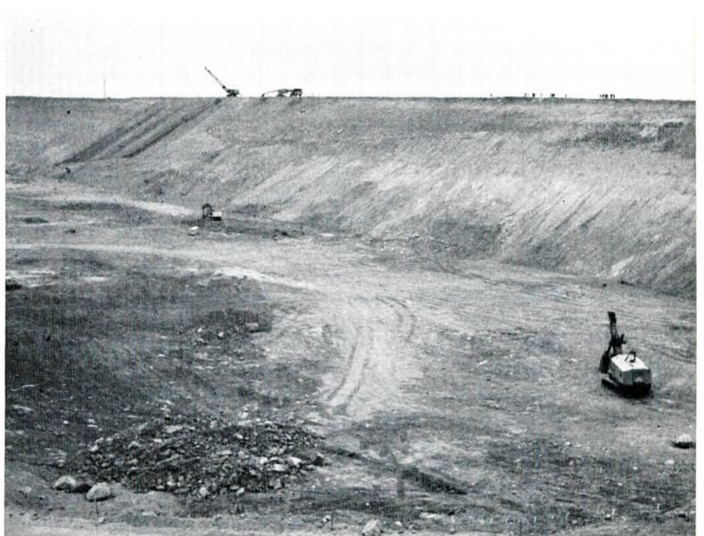
Bild 4 Teilansicht des oberen, rund vier Mio m³ fassenden Pumpspeicherbeckens der Hornbergstufe. Hinsichtlich der Dimensionen beachte man die Menschen auf der Dammkrone.
