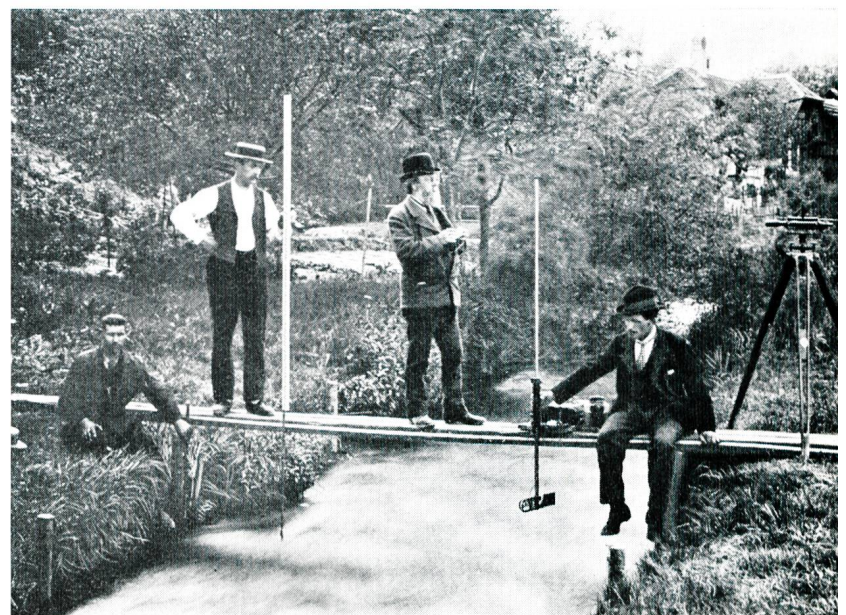
Bild 1 Dr. h. c. J. Epper, dipl. ing. ETH, ehemaliger Direktor der Abteilung für Landeshydrographie, bei einer Wassermessung an der Worblen (auf Stegmitte, um 1905). Versuch mit einer von ihm konstruierten Halterung für die Flügelstange.
