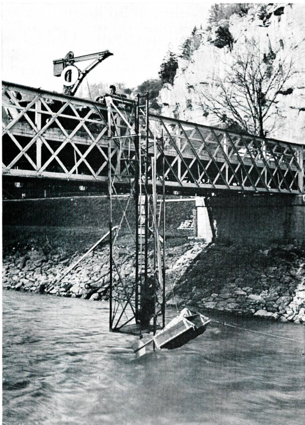
Bild 8 Besondere Untersuchungen: Geschiebemessungen an der Aare bei Brienzwiler 1936–37.
