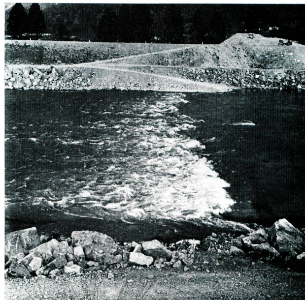
Bild 17 Blockschwelle im Rhein bei Buchs, ausgeführt im Jahre 1971.
