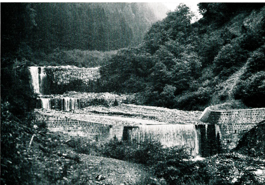
Bild 3 Neuere Sperre in der Nolla. Der Seitendruck vom linken Hang wird durch den verkleideten Damm aufgenommen.
