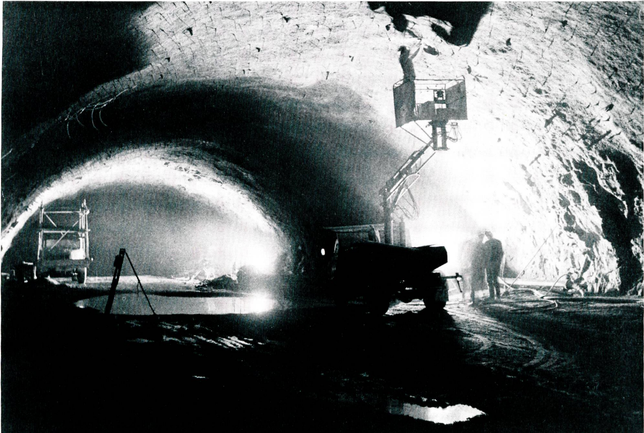
Bild 16 Felsausbruch der Kalotte für das Kavernenkraftwerk Wehr
