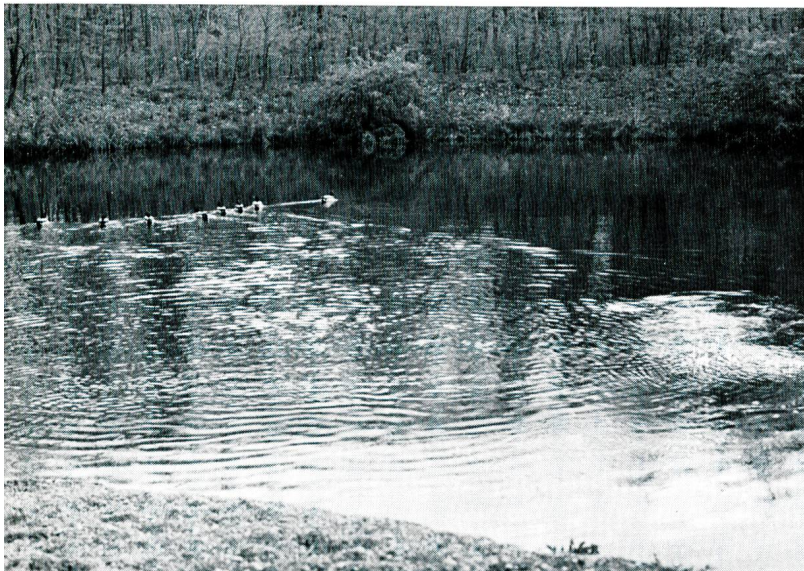
Bild 2b Sickerweiher der Hardwasser AG in der Muttenzer Hard mit Rundkiessohle, Wassertiefe ca. 3 m.
