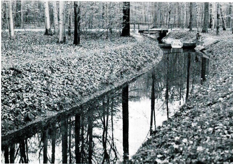
Bild 2a Sickergraben der Hardwasser AG in der Muttenzer Hard Sohlenbreite 2 m, Rundkiessohle 40 cm hoch, Körnung 5 bis 10 mm, Wassertiefe ca. 80 cm.
