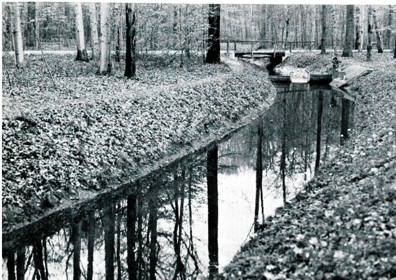
Bild 2a Sickergraben der Hardwasser AG in der Muttener Hard Sohlenbreite 2 m, Rundkiessohle 40 cm hoch, Körnung 5 bis 10 mm, Wassertiefe ca. 80 cm.
