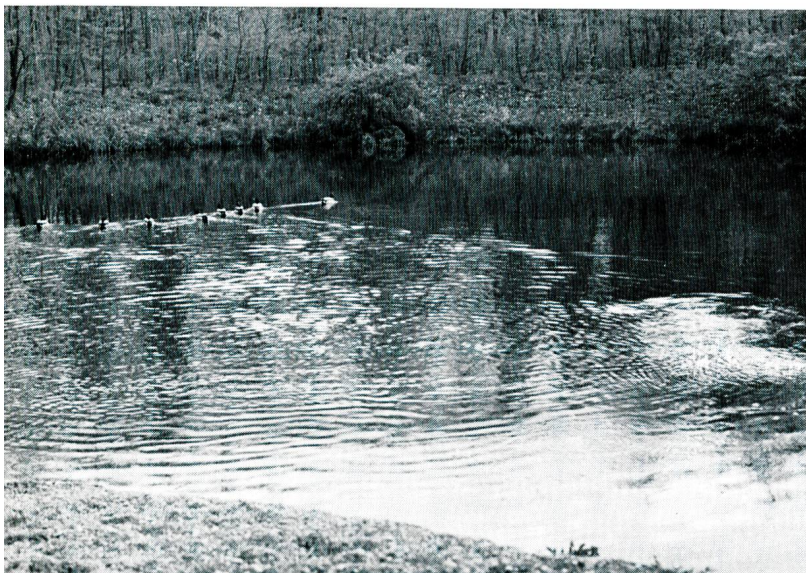
Bild 2b Sickerweiher der Hardwasser AG in der Muttener Hard mit Rundkiessohle, Wassertiefe ca. 3 m.
