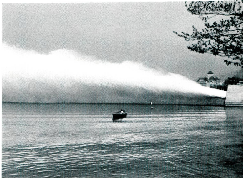
Bilder 5 und 6 Eindrucksvolle Demonstration der Wasserentlastung aus dem Stausee Hongrin. Bei der Demonstration wurden während etwa 7 Minuten maximal 20 m 3 /s in einen etwa 250 m langen Wasserstrahl geworfen.
