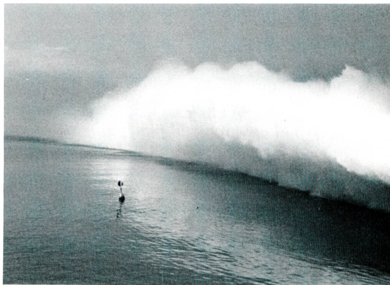
Bilder 5 und 6 Eindrucksvolle Demonstration der Wasserentlastung aus dem Stausee Hongrin. Bei der Demonstration wurden während etwa 7 Minuten maximal 20 m 3 /s in einen etwa 250 m langen Wasserstrahl geworfen.
