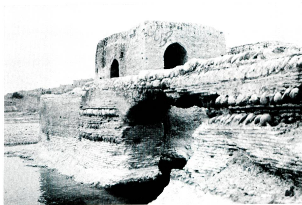
Bild 30 Römische Mauertechnik am Wehr in Disful.
