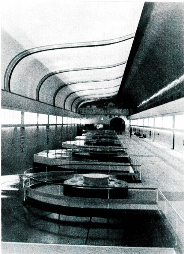
Bild 8 Kavernenzentrale Kariba in Rhodesien, erbaut 1955 bis 1959. Installierte Leistung 6 \times 100 \text{ MW} = 600 \text{ MW} . Eine Zentrale gleicher Leistung ist zurzeit am Ufer von Sambia im Bau.
