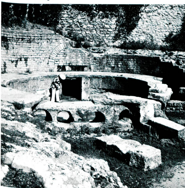
Bild 4 Das «Castellum divisorium aquae» in Nîmes; im Hintergrund der Einlauf des Aquäduktes in das Rundbecken von etwa 30 m 3 Nutzhalt, vorn einige der zehn Austritte zu den fünf doppelsträngigen Hauptverteilungen.
