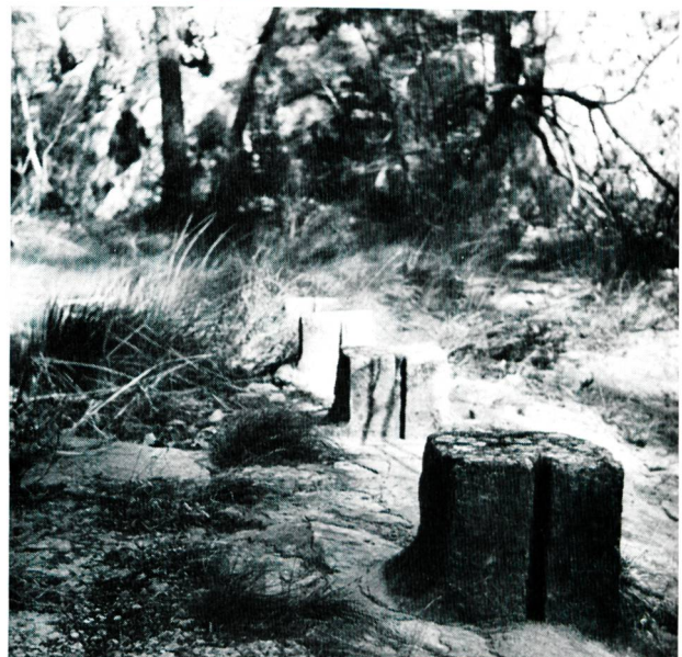
Bild 12 Ueberbleibsel des die «Petite mer» am Infernet aufstauenden, etwa 3 m hohen Wehres aus dem 17. oder 18. Jahrhundert; die Pfeiler mit Dammbalkennuten sind etwa 40 cm hoch.
