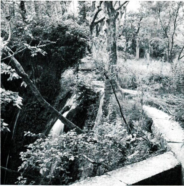
Bild 11 Ruine einer kleinen Bogenstaumauer unbestimmten Alters unmittelbar oberwasserseitig der römischen Mauer von Tholonet; ganz links ein intakter Mauerdurchlass, in Bildmitte die stehengebliebene Hälfte eines solchen.
