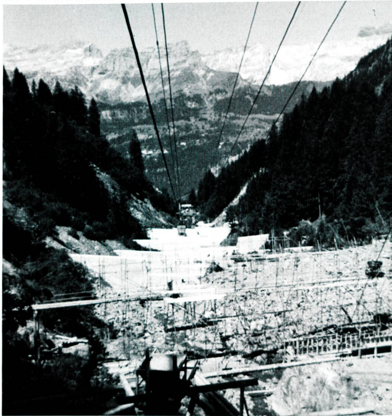
Bild 4 Im Bau stehende Wildbachsperren im oberen Durnageltobel.
