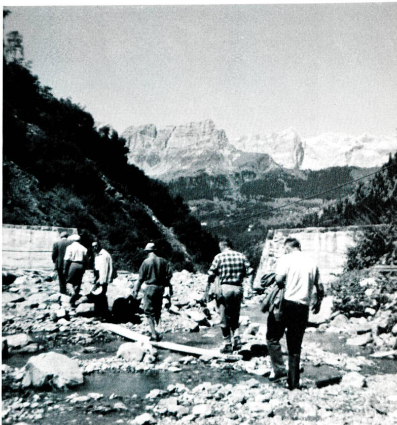
Bild 7 Abstieg von Sperre zu Sperre.
