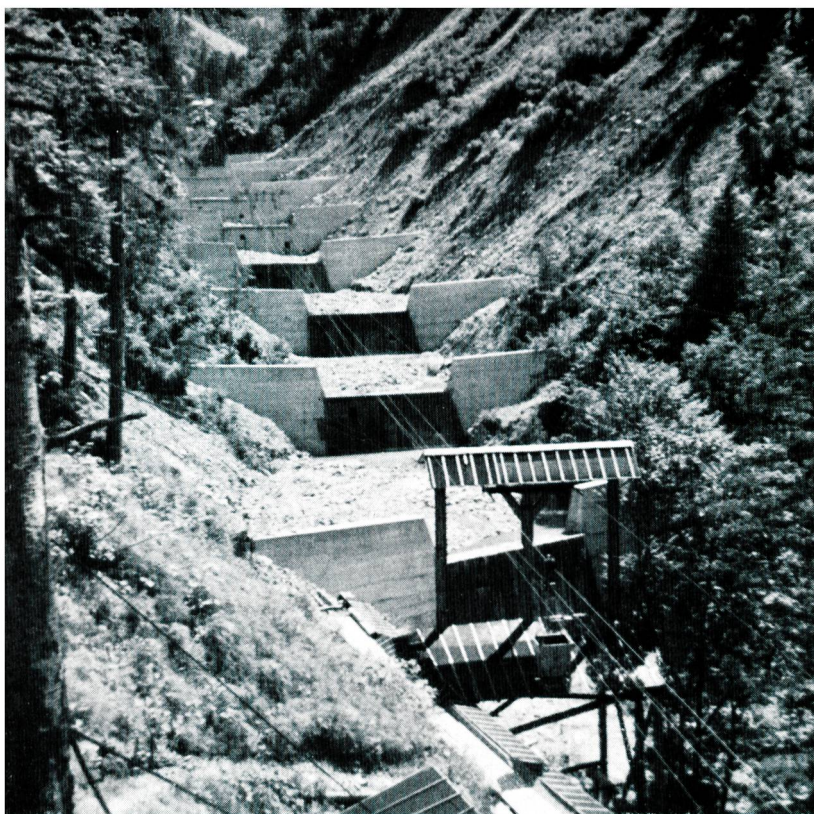
Bild 9 Sperrentreppe im Durnageltobel.
