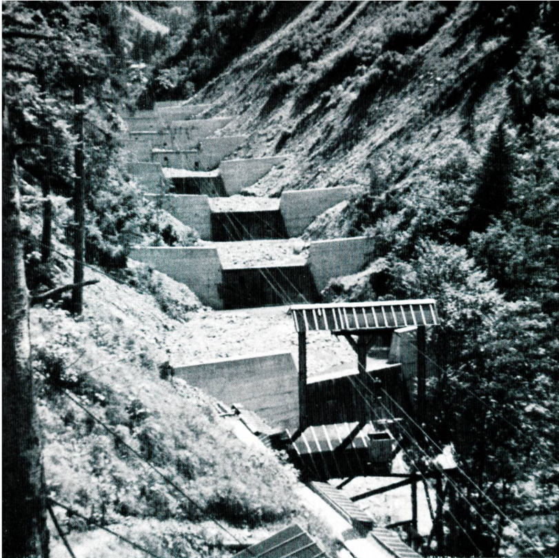
Bild 9 Sperrentreppe im Durnageltobel.
