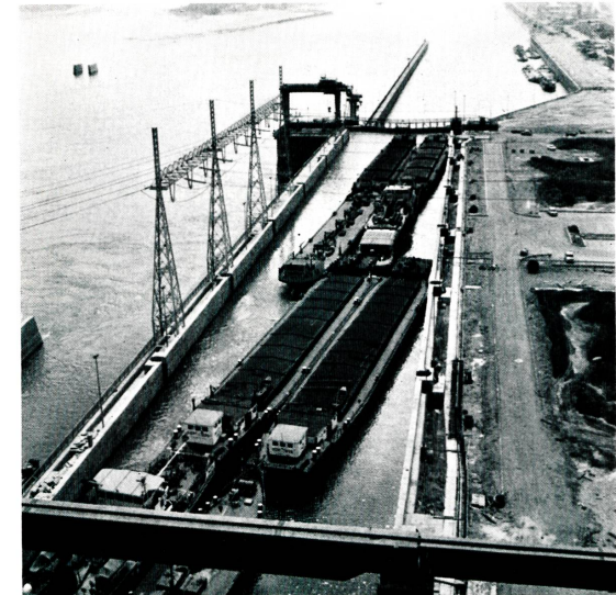
Bild 7 Blick donauabwärts in das untere jugoslawische Schleusenbecken der Staustufe «Eisernes Tor».
