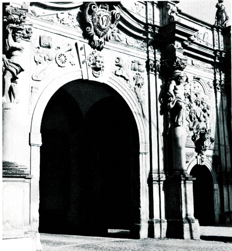
Bild 14 Befestigte Stadtmauer in Alba-Julia/Karlsburg.
